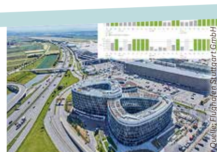
Anlagenbetriebsqualität auf einen Blick.
