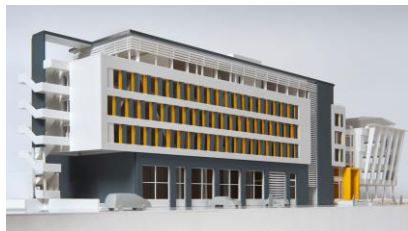
synavision optimierte das Gebäude der Schöck Bauteile GmbH in Baden-Baden
