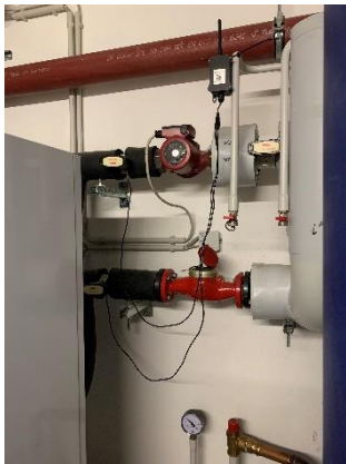
Abbildung 1: Der kleine schwarze Sensor – hier oben im Bild – kann ohne technische Expertise an den Vor- und Rücklauf einer Heizanlage angeschlossen werden.
